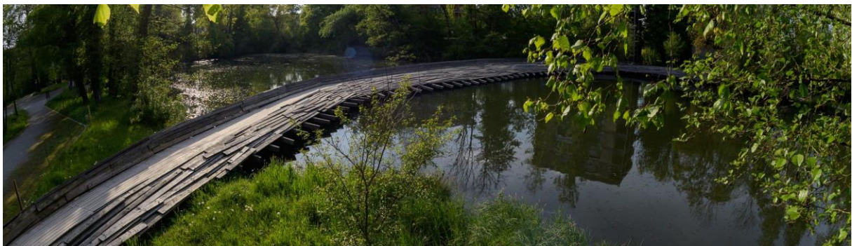
Die Kawamata-Brücke in Uster. Sie ist das Key Visual der internen Kommunikationskampagne und steht in der KI-Einführung für den Weg in eine neue Arbeitswelt.
